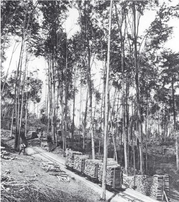
In Folge der Nassschnee-Schäden vom 28. September 1885 in den Beständen des Sihlwaldes wurde eine temporäre Eisenbahn zur Abfuhr von Brennholz eingerichtet. Foto U. Meister, 1886 (aus MEISTER, 1903).
